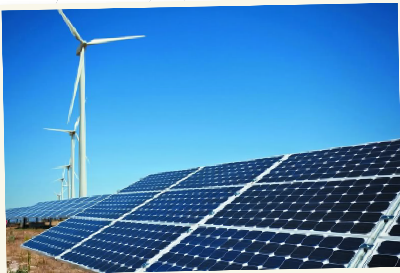
Sistemas Fotovoltaicos y Eólicos
